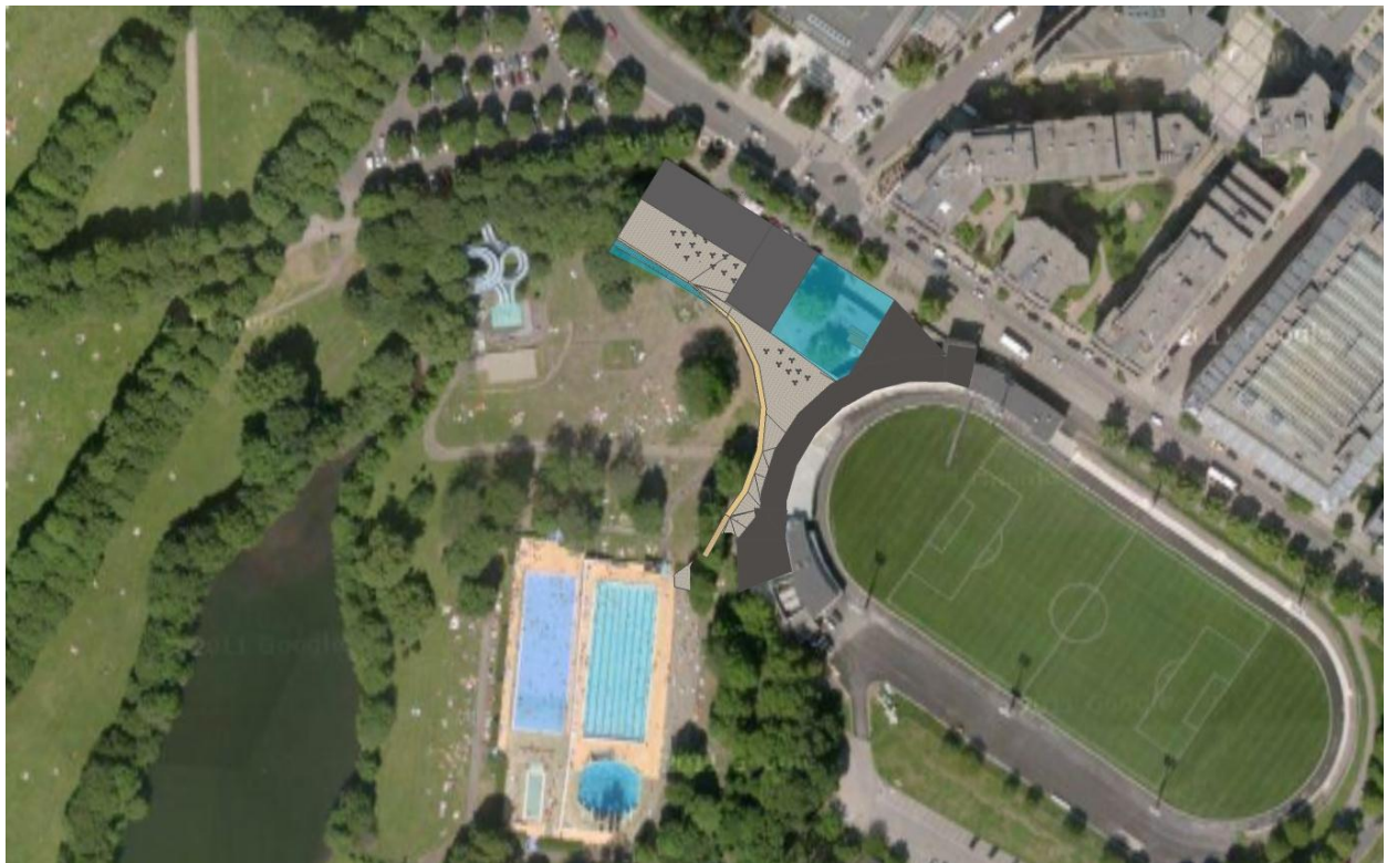
Figur 2 - Synlige deler av byggetrinn 1, 2 og 3
